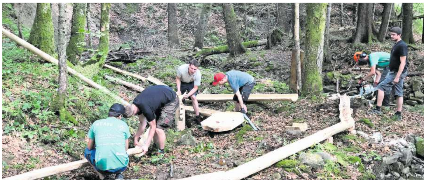
Handarbeit für den Brätelspass: Freiwillige Helfer erstellen auf der Wolzenalp eine «Schweizer Familie»-Feuerstelle. Bild: PD
